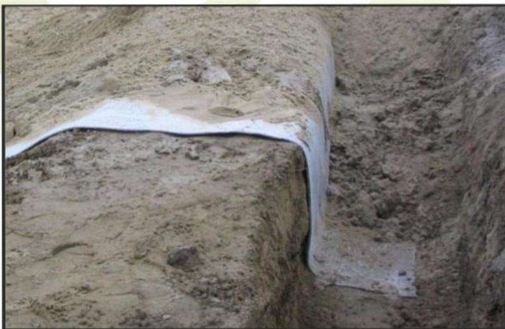
Рис. 2 Устройство анкерного замка
