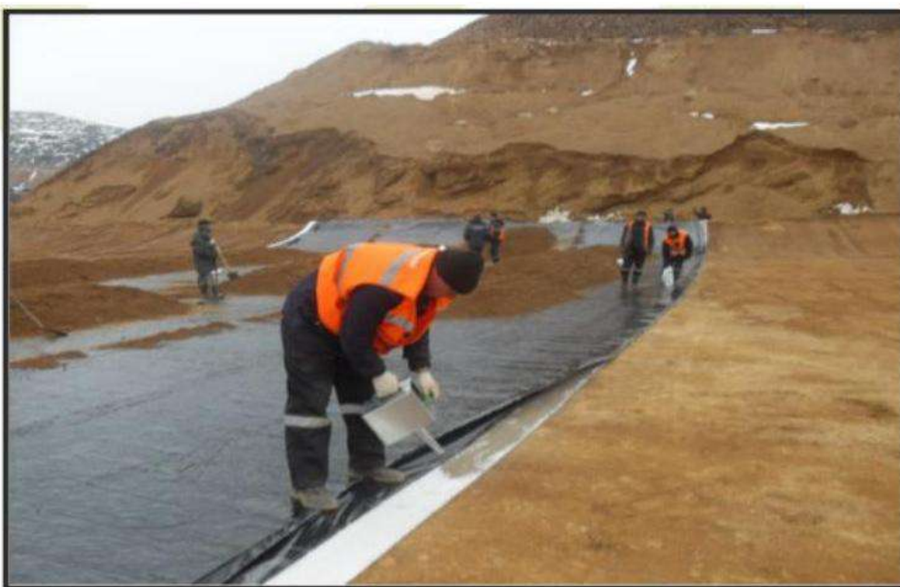
Рис. 4. Просыпка зоны нахлеста бентонитовыми гранулами
