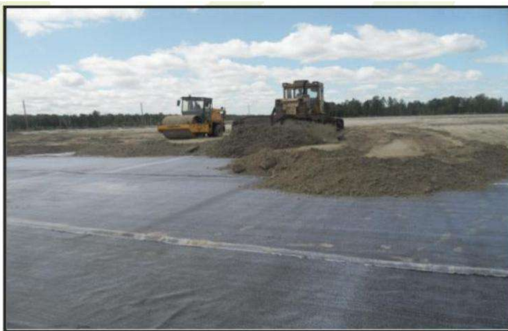
Рис. 6 Устройство обратной засыпки
