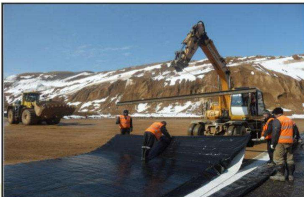
Рис. 3 Укладка бентонитового мата
